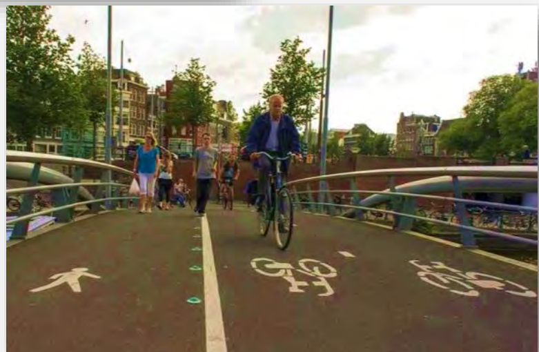
Figur 38. Exempel på bred GC-väg, i detta fall brokonstruktion.
