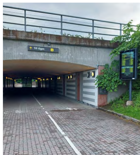
Figur 34. GC-tunneln vid stationen.
