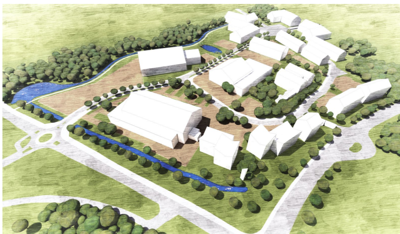
Figur 7. Vy från nordöst (ovanför trafikplats Annelund)
