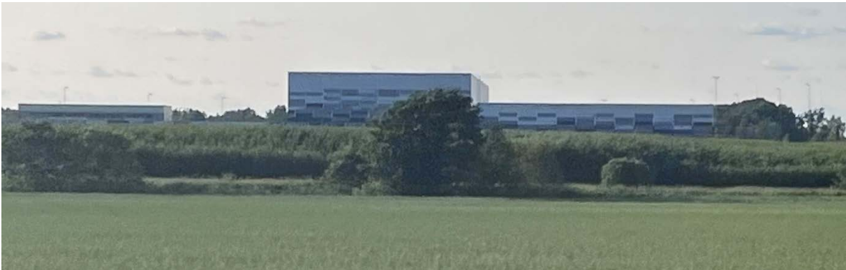
Bild 39. Referensbild logistikbebyggelse, med viss andel höglager. Tyréns. 2023
