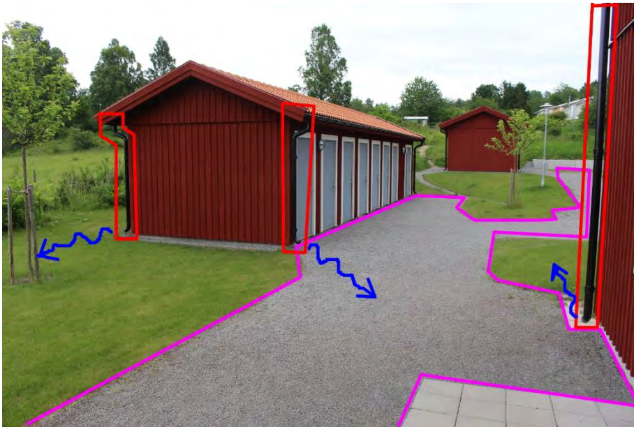
Figur 15. Avrinnande dagvatten från takytor leds via utvändiga stuprör (rödmarkerade för tydlighet) till gröna ytor samt grusade ytor och gångytor (markerade med magenta).
