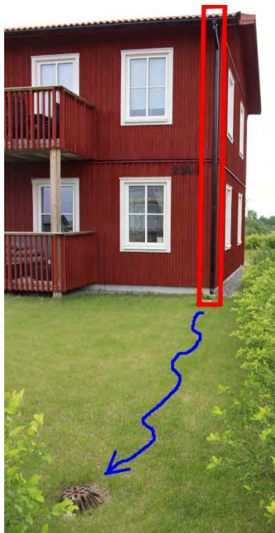
Figur 13. Avledning av takvatten via utvändigt stuprör (inringat i rött) till grön yta. Diffus spridning underlättas via platsättning under stupröret (ej synligt på fotot). Dagvattnet har därefter en längre sträcka till avledning via dagvattenbrunn, demonstrerat med blå pil.
