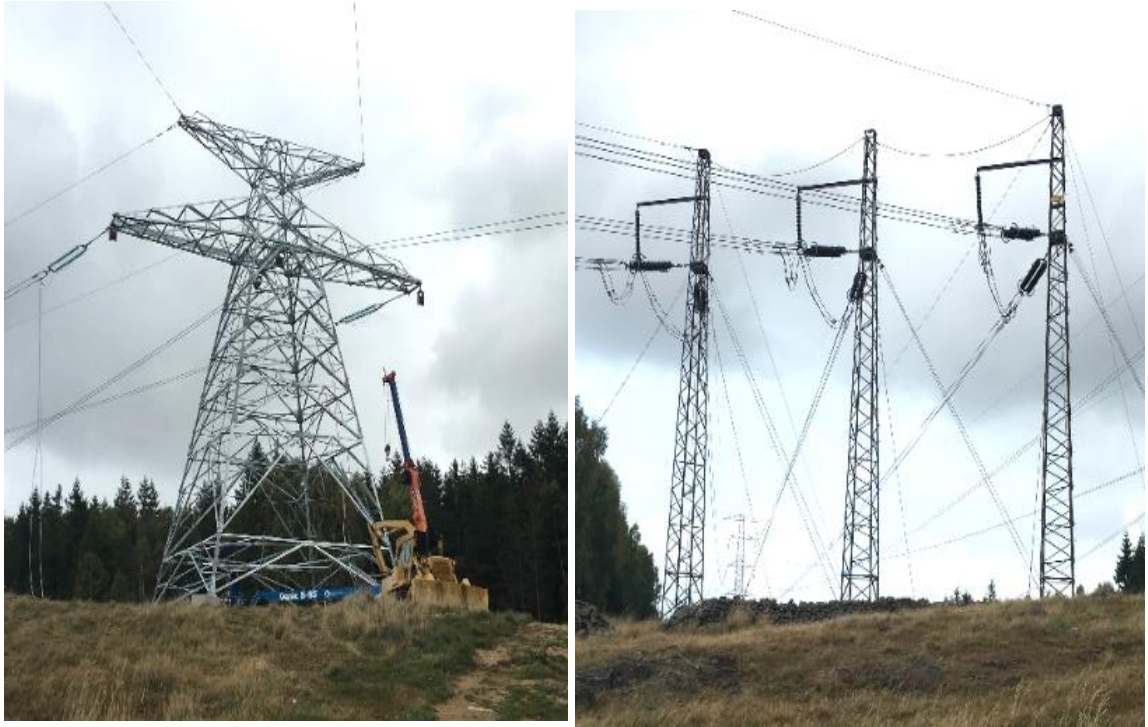
Figur 3. Exempel på vinkelstolpar. Till vänster en stubbe och till höger en traditionell vinkelstolpe.
