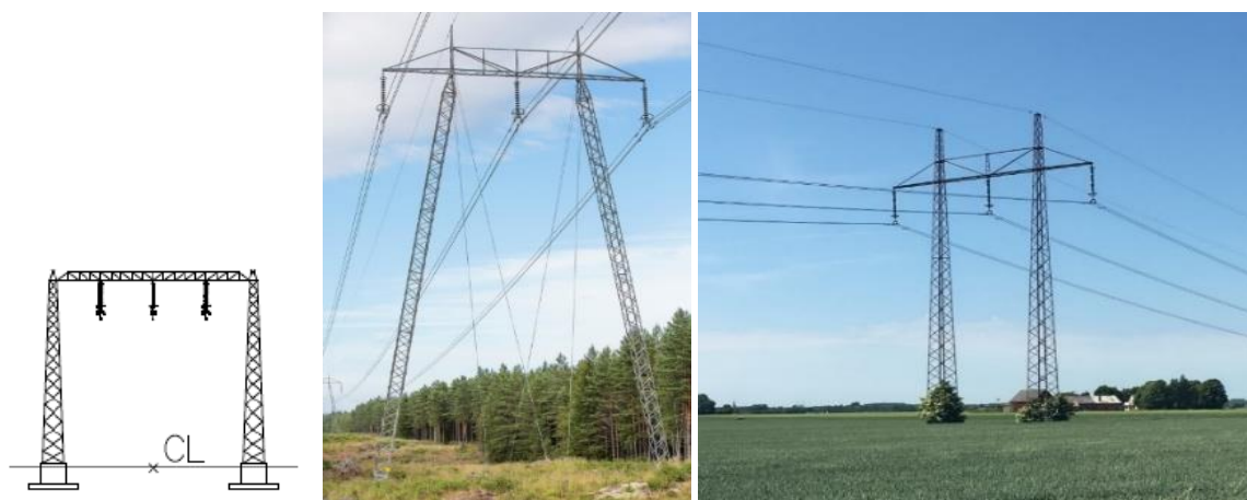
Figur 2. Principskiss på lågbyggd portalstolpe för 400 kV till vänster, en stagad A-stolpe som används i skogsmark i mitten och till höger en ostagad B-stolpe som används i öppna marker.
