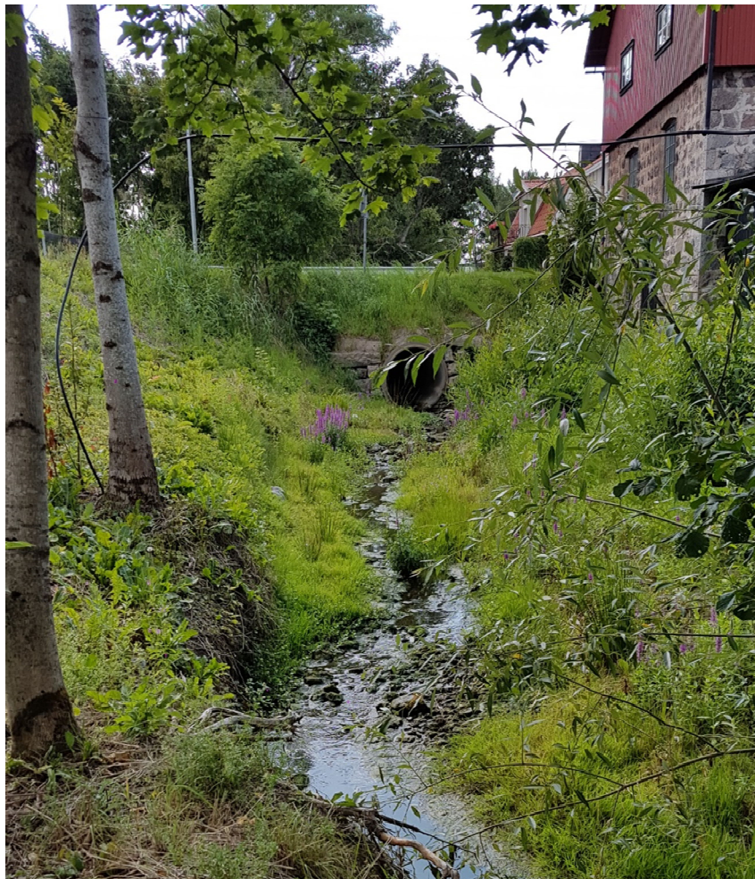
Bilden visar Fiskviks kanal och trumman under Grillbyvägen, strax uppströms planområdet
